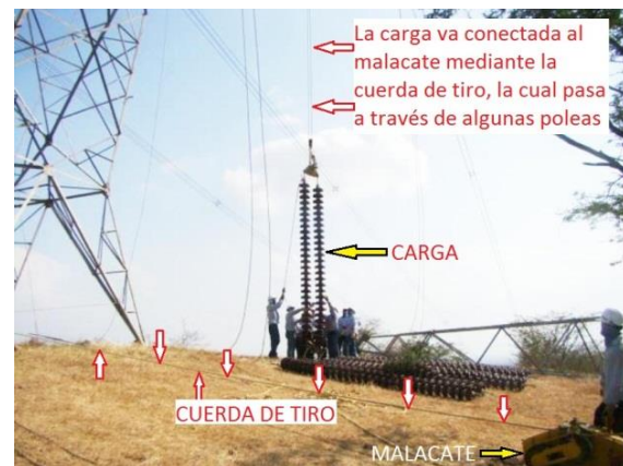
Fig 2 – Conexión malacate - carga
