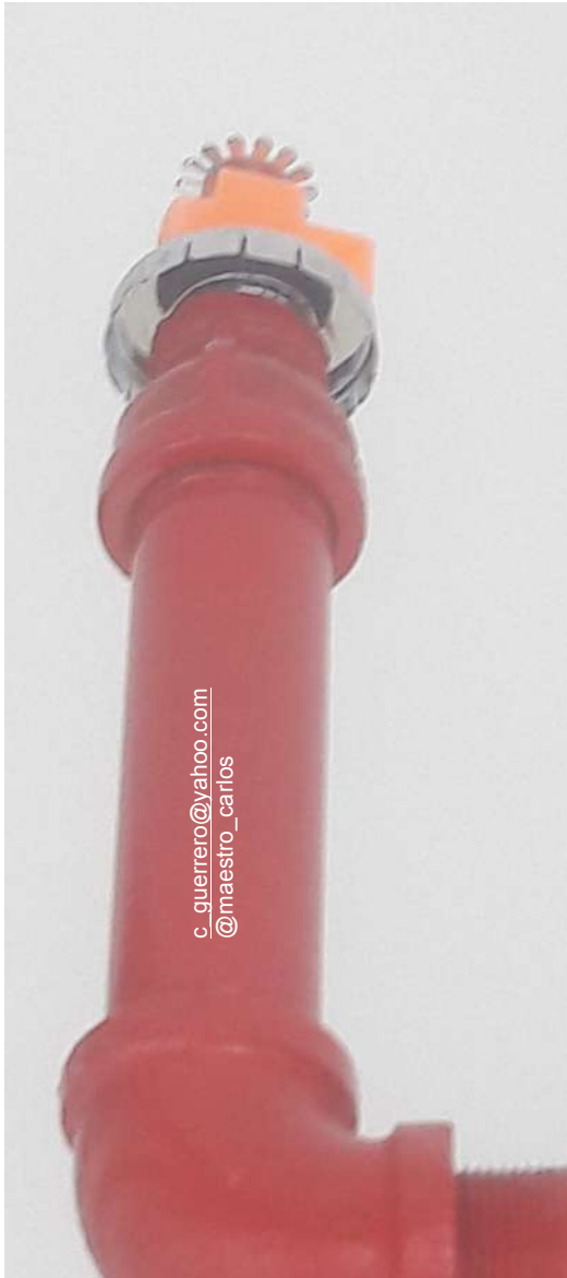
Foto #13: Inspección de Rociadores. Notar que es un rociador pendiente instalado mal (como montante).
