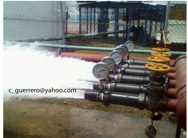
Foto #12: Prueba anual de operación de bomba contra incendios
