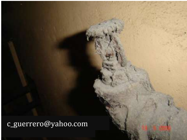
Foto #2: Rociador sin inspección o mantenimiento
