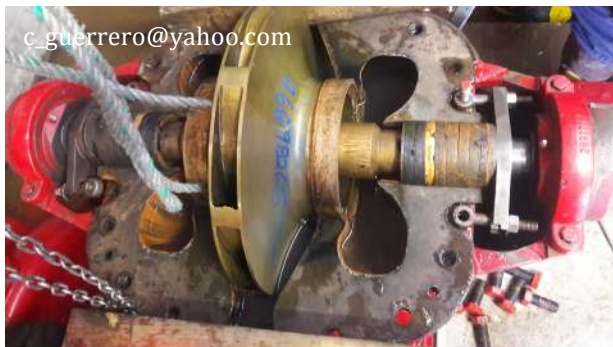
Foto #3: Mantenimiento a bomba contra incendios
