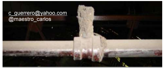
Foto #14: Rociador con años sin mantenimiento, tapado totalmente por sucio y telarañas
