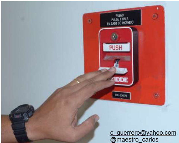
Foto #15: Prueba anual de estación manual
