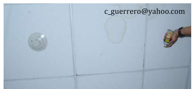
Foto #5: Prueba anual de alarma a sensor de humo fotoeléctrico
