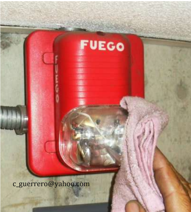
Foto #6: Mantenimiento anual de luz estroboscópica
