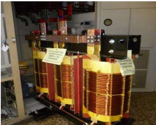
Fig. 19. Nuevo transformador de excitación 780kVA.
