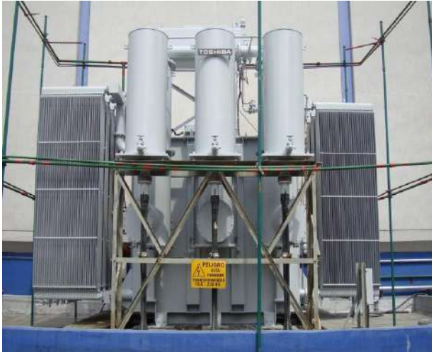
Fig. 7. Transformador principal de 115MVA.
