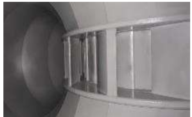
Fig. 21. Caracol y pre-distribuidor de la Unidad 1 de Salvajina después del tratamiento de pintura.
