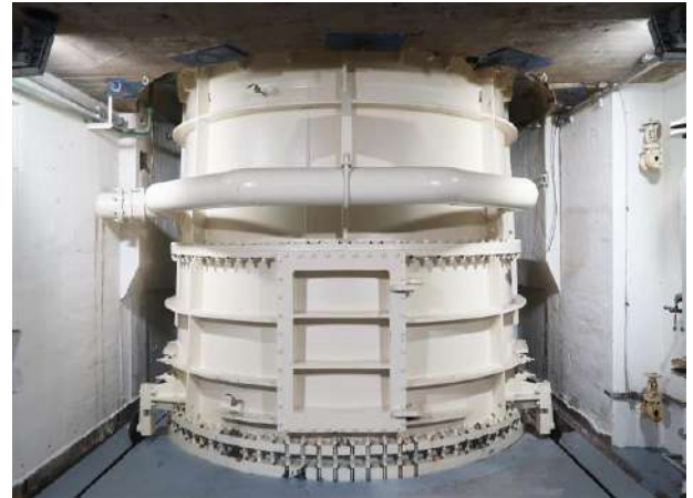
Fig. 20. Tubo de aspiración nuevo de la Unidad 1 de Salvajina.
