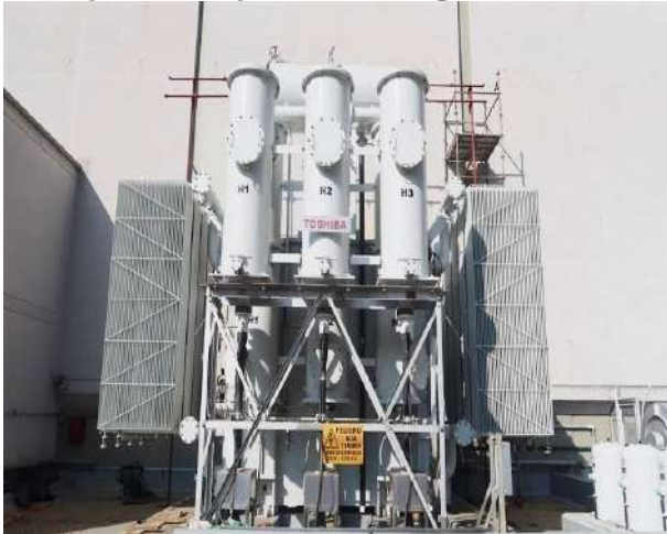
Fig. 15. Transformador principal de 125MVA nuevo.
