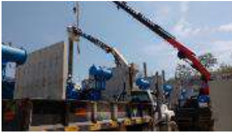
Figura 4. Montaje de reactor de línea.
