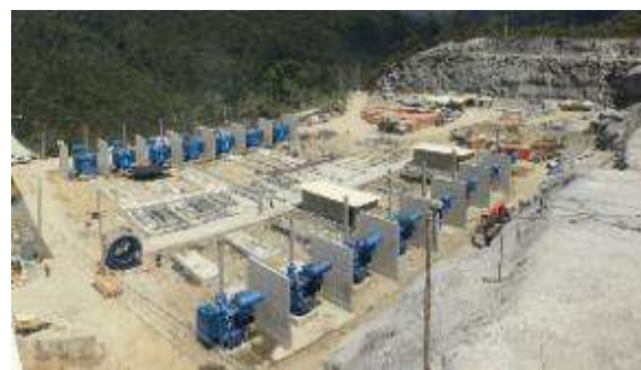
Figura 2. 15 reactores de línea, S/E Antioquia, Colombia.
