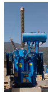
Figura 1. Reactor de línea monofásico.
